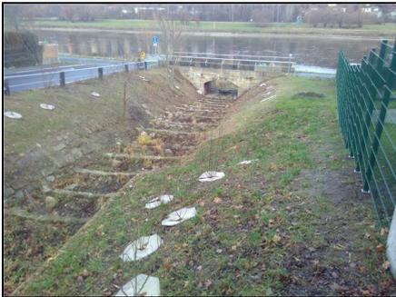
Abb. 3: Nach der Maßnahme: Ufermauer weitestmöglich abgebrochen und Böschung mit standortgerechten Bäumen und Sträuchern bepflanzt, 16.12.2019
