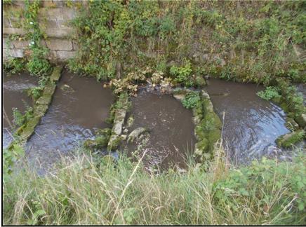
Abb. 2: Vor der Maßnahme: starke Strömung an Beckenauslässen, 07.05.2015
